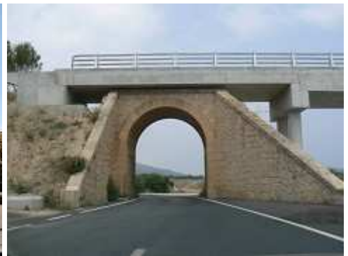
Auch diese Brücke wurde bereits 2006 saniert und mit einem neuem Überbau versehen, Bilder 1 und 2 April 2012, Bilder 3 und 4 aus 2006, Bild 5 aus 2007. Bild 6 zeigt die Trasse in Richtung Son Carrio parallel zur Landstraße MA 4022 im April 2012.
