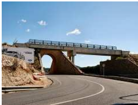
Auch diese Brücke wurde bereits 2006 saniert und mit einem neuem Überbau versehen, Bilder 1 und 2 April 2012, Bilder 3 und 4 aus 2006, Bild 5 aus 2007. Bild 6 zeigt die Trasse in Richtung Son Carrio parallel zur Landstraße MA 4022 im April 2012.
